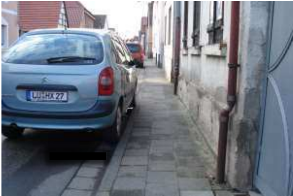
Abbildung 5-6: Enge Fahrbahn in Langgasse führt zu Gefahrensituationen und Verengung der Gehwege
