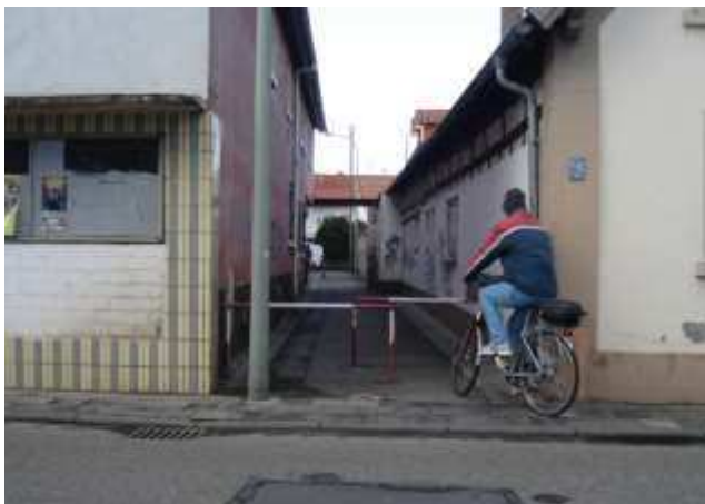
Abbildung 5-19: Umlaufsperrn („Drängelgitter“) sind auf Radverbindungen ein Hindernis, insbesondere für Fahrräder mit Anhänger und Kinderwägen.
