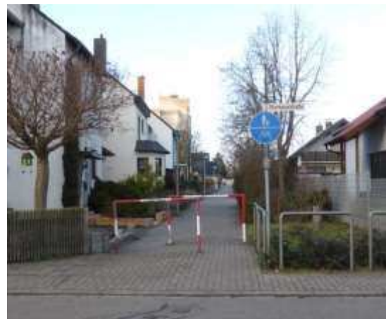
Abbildung 5-19: Umlaufsperrn („Drängelgitter“) sind auf Radverbindungen ein Hindernis, insbesondere für Fahrräder mit Anhänger und Kinderwägen.
