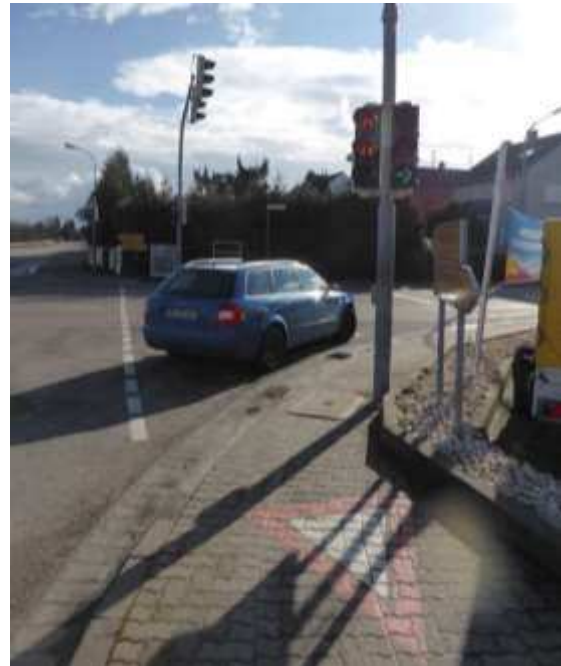
Abbildung 5-18: Am Radweg entlang der Iggelheimer Straße (L 528) ist die Vorrang-Regel außer Kraft gesetzt: an zwei Einmündungen muss der Radfahrer auf dem Radweg den abbiegenden Pkw abwarten.
