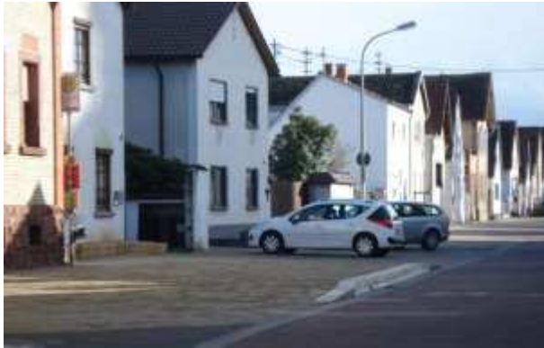
Abbildung 5-15: Bushaltestelle „Luitpoldstraße“ nach Straßenumbaumaßnahme: mit vorgezogenem Halterand und Hochbord, jedoch ohne überdachte Wartemöglichkeit (trotz ausreichendem Platzangebot)
