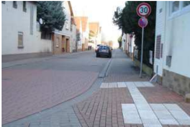
Abbildung 5-22: Blindenleitsystem, eingerichtet im Rahmen der Straßenumgestaltung
